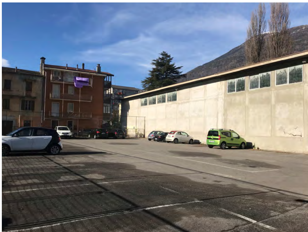
Foto 4: fronte parcheggio interno
