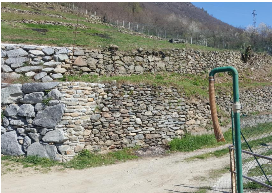
Figura 17 – stato di fatto dell’attuale muro di sostegno
